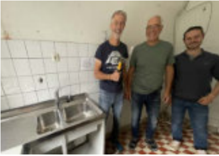
Das „Abbruch-Team“: (von links nach rechts) Holger Schauerte, Reinhard Post, Alexander Varshavskiy
